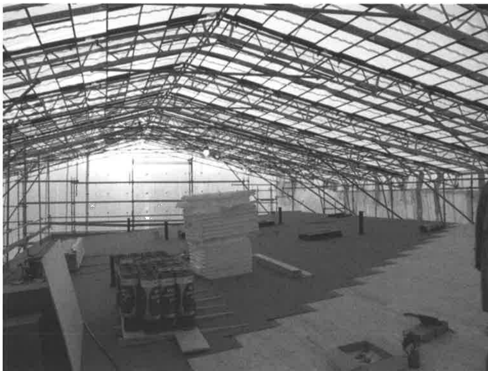
Figur 6. Interiör från nybyggnadsprojekt med fast takväderskydd.
