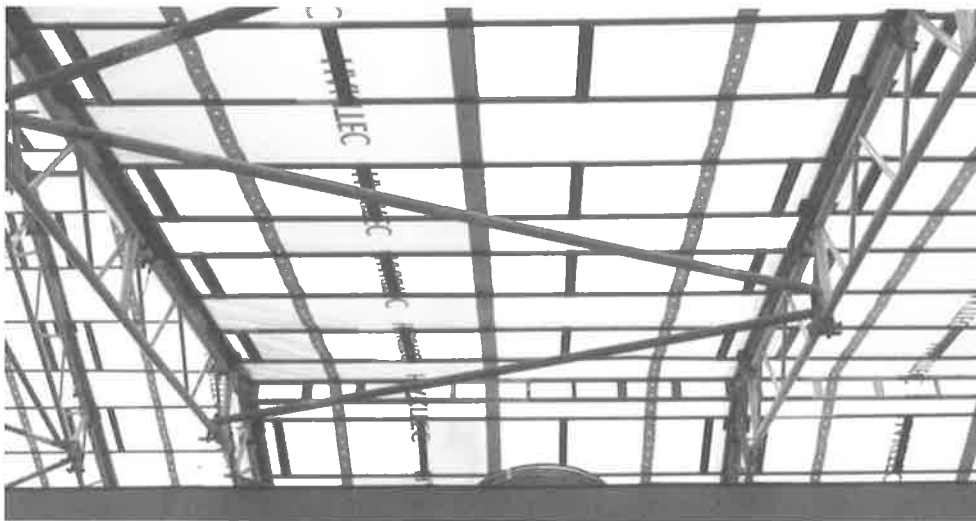
Figur 19. Vädskyddet sett inifrån
