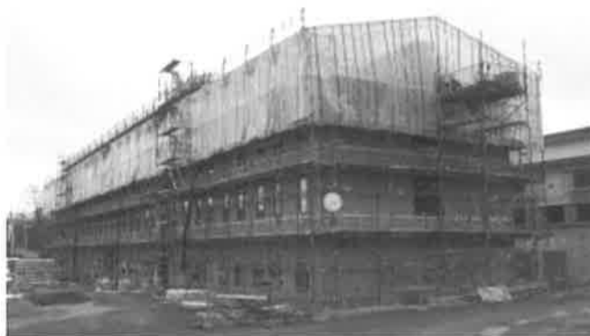
Figur 29. Väderskyddets konstruktion
