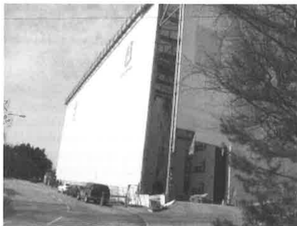
Figur 26. Produktionshallen på plats vid ett annat husbyggnadsprojekt
