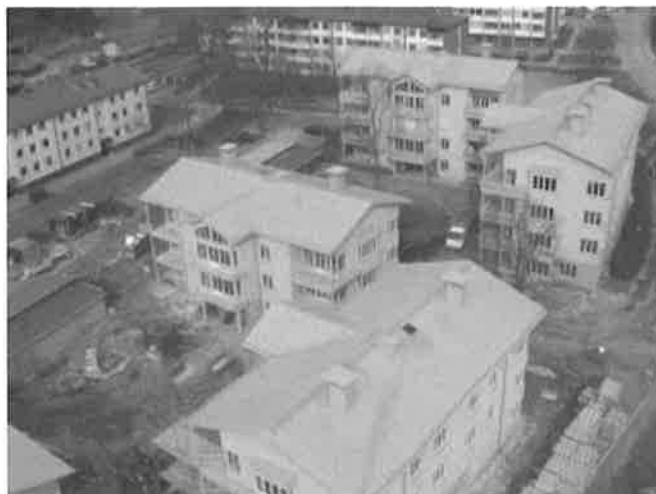
Figur 27. De färdigbyggda flerbostadshusen i brf Runhällen, Vallentuna.
