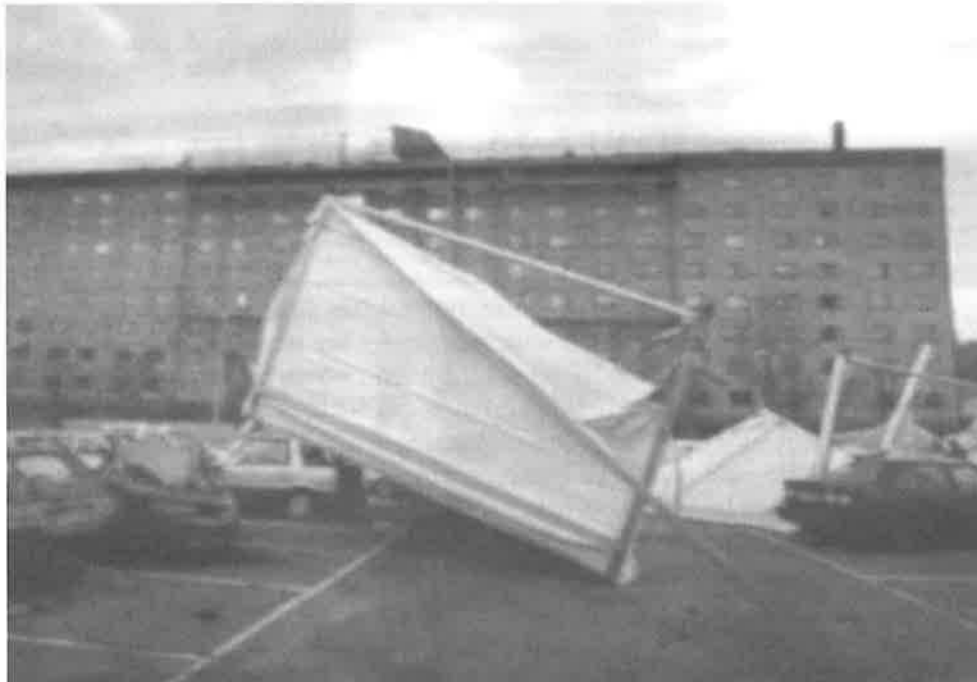
Figur 13. Haveri av takväderskydd på grund av otillräcklig förankring för vindlast.
