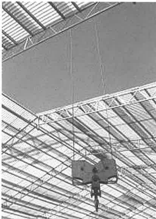
Figur 23. Inlastning i väderskydd Aqua-Täck
