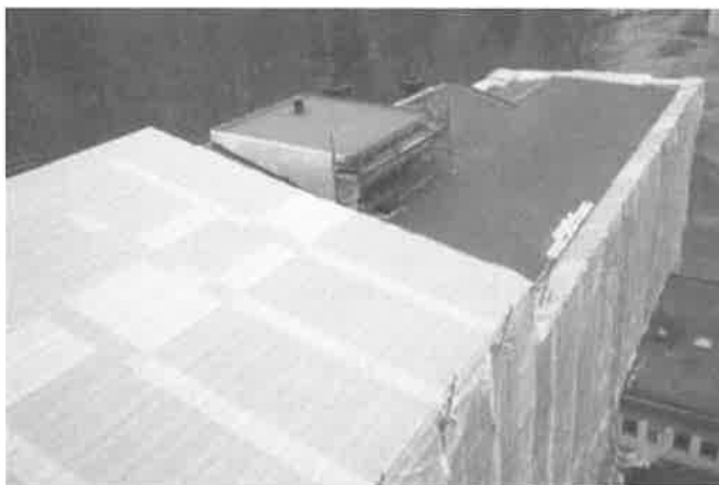
Figur 33. Intäckning av halva taket i projekt Bodaklint
