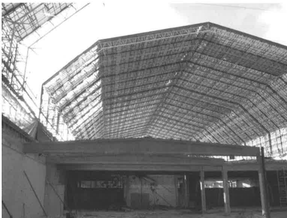
Figur 8. Karlstads universitet. Mobilt takväderskydd vid större om- och tillbyggnad. Spännvidd 33 m.
