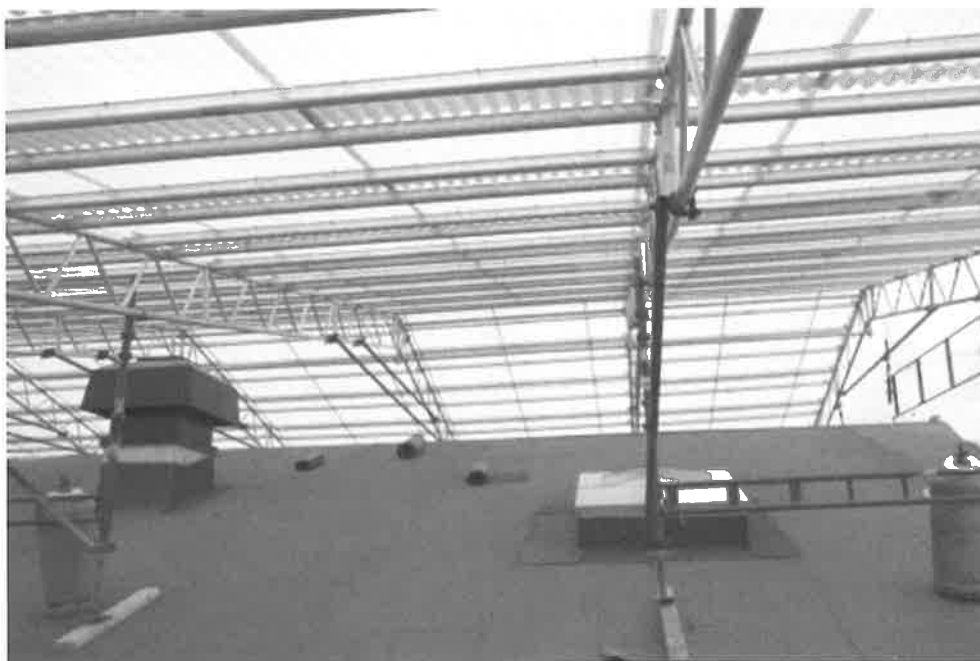
Figur 22. Väderskydd Aqua-Täck med Layher modulställning som bärande konstruktion
