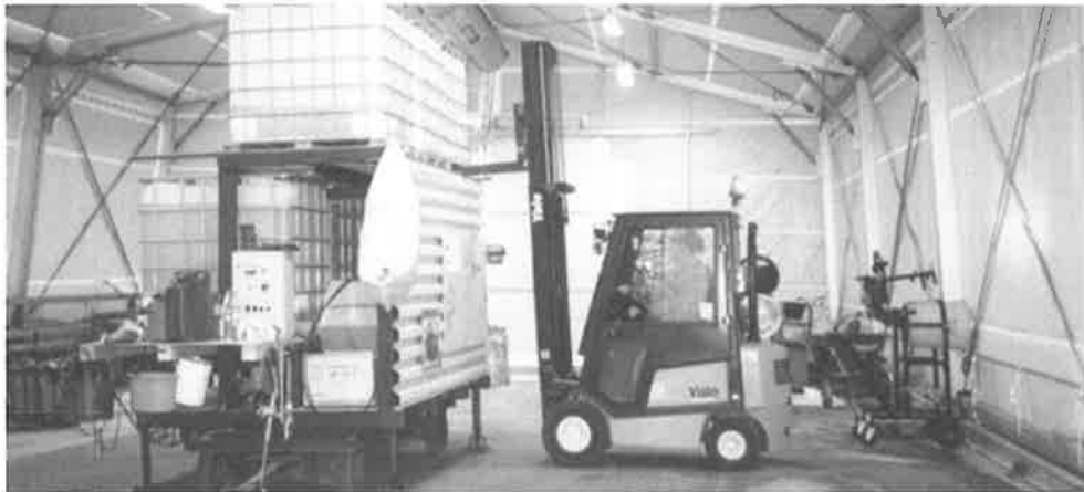
Figur 3. Öresundsbron. Materialhantering inne i väderskyddet.
