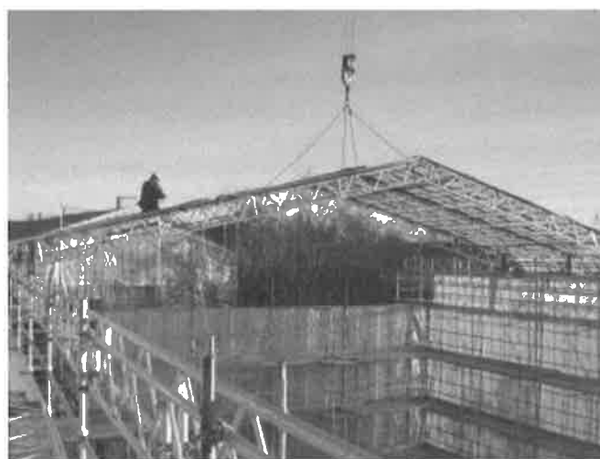
Figur 28. Det mobila takväderskyddet lyfts på plats.
