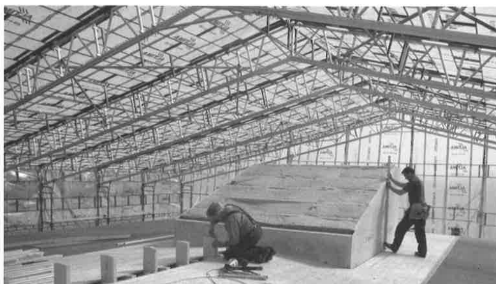
Figur 15. Arbete i HAKITEC väderskydd
